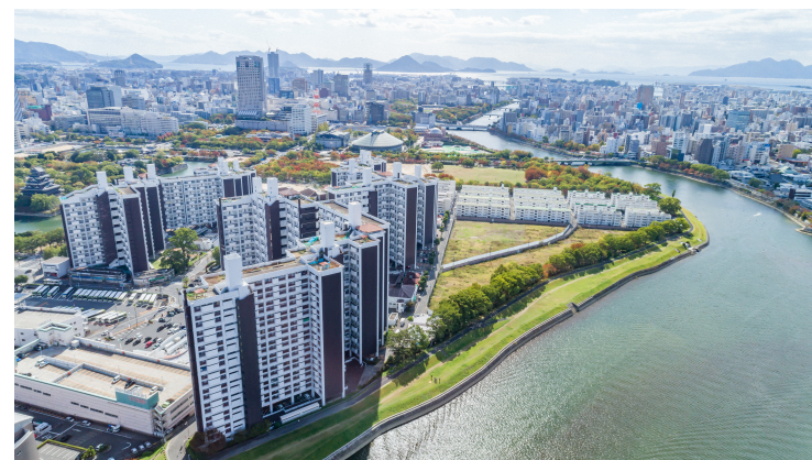
北側から見た敷地
