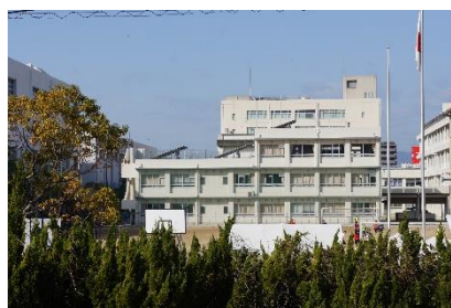
(東校舎) 屋上に 三組設置
