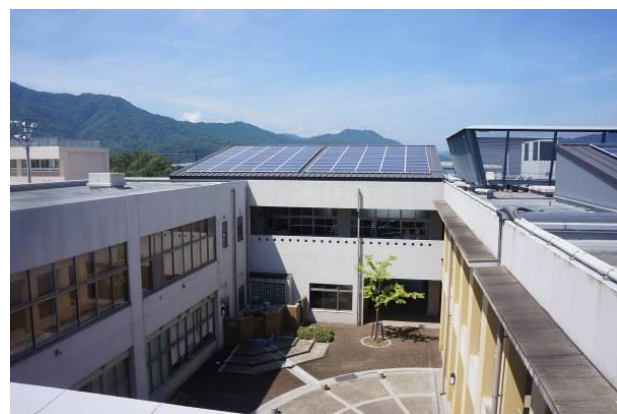
(太陽光発電施設)
