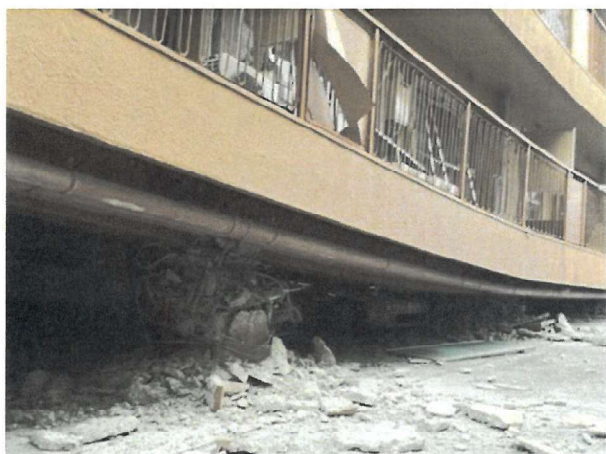
【被害例】1階が駐車場などのピロティ式の建物の場合の被害
