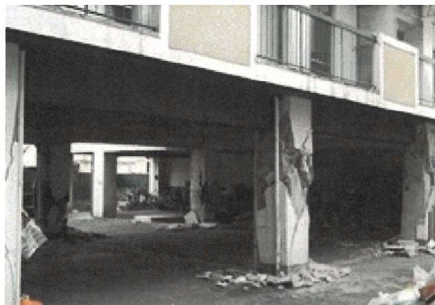
【被害例】1階が駐車場などのピロティ式の建物の場合の被害
