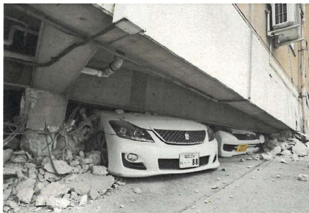
【被害例】1階が駐車場などのピロティ式の建物の場合の被害
