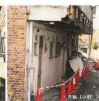
外壁、手すりが崩落した事例
