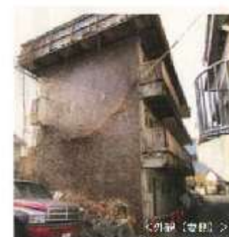
外壁、手すりが崩落した事例
