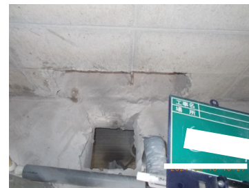
既設撤去 スラブ研り
