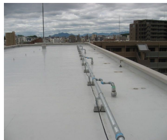
新規経路配管及び切替、既設配管撤去
