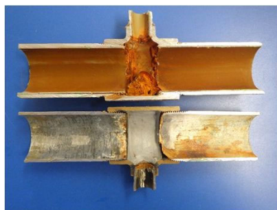
配管縦割り 半分は内面処理
