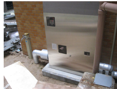
増圧ポンプ新設
