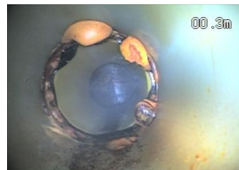
ゲート弁継手部
