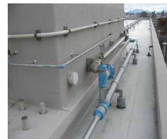
新規経路配管及び切替、既設配管撤去
