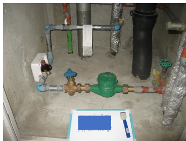
メ-タ- 1 次側更新・減圧弁新設
