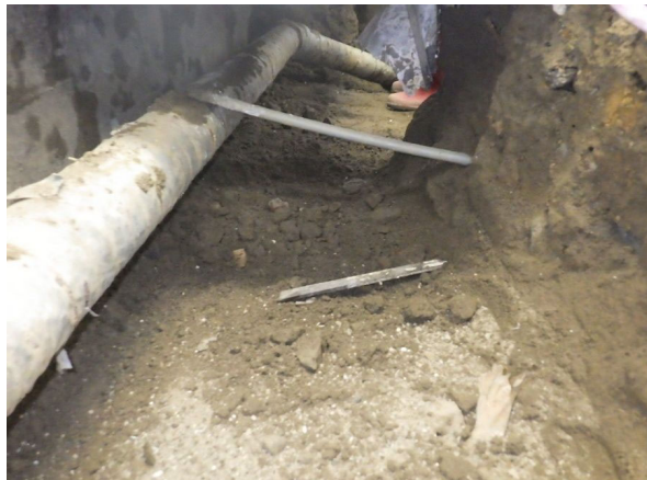
1 階室内土間下排水管
