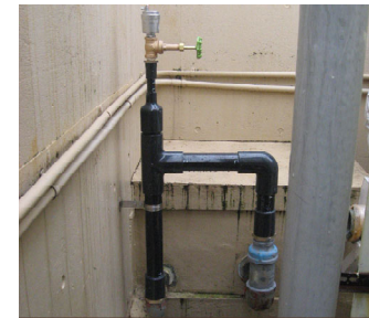
屋上給水管切替
