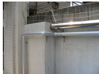
屋外配管保温
