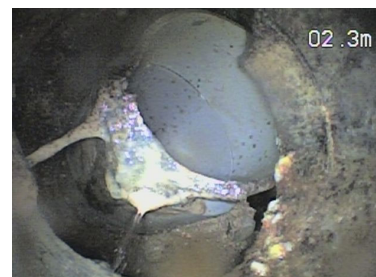
横引管破断
