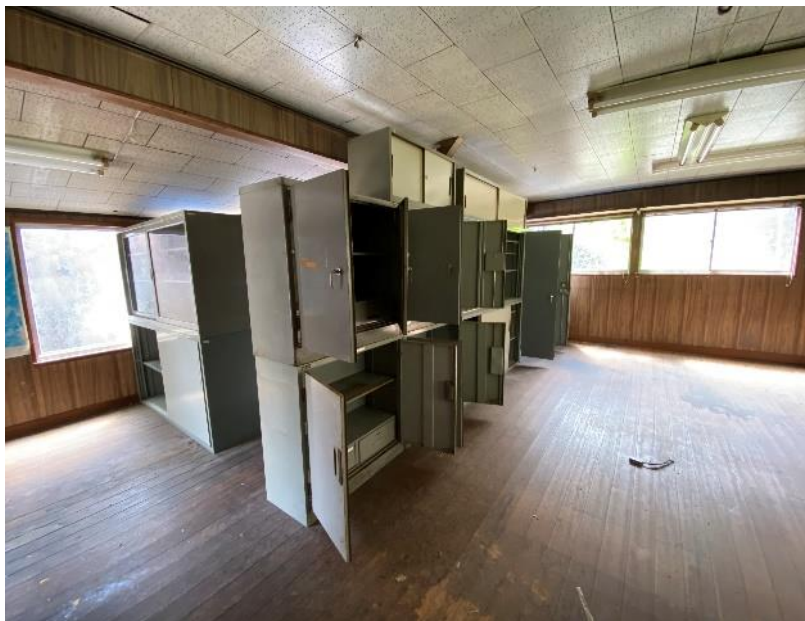
監査人撮影（当建物内部）
