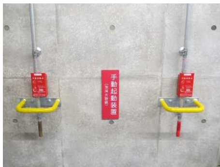
手動起動装置に保護ガードを設置
