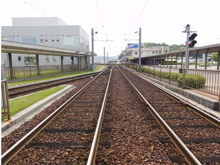
図 2-8 バラスト軌道
