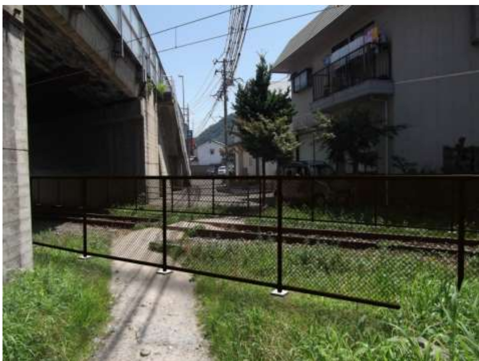
写真－No. 5 電化延伸区間
