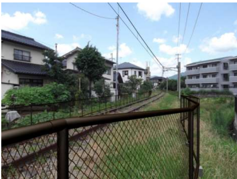
写真－No. 6 電化延伸区間
