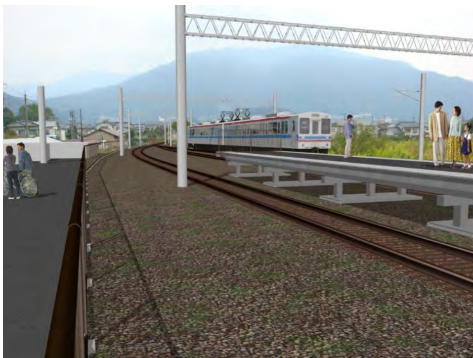
写真－No. 7 電化延伸区間
