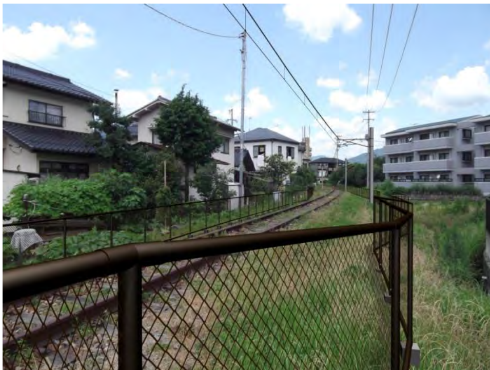
写真－No. 6 電化延伸区間
