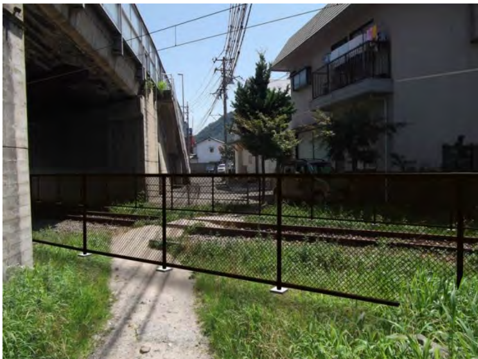
写真－No. 5 電化延伸区間
