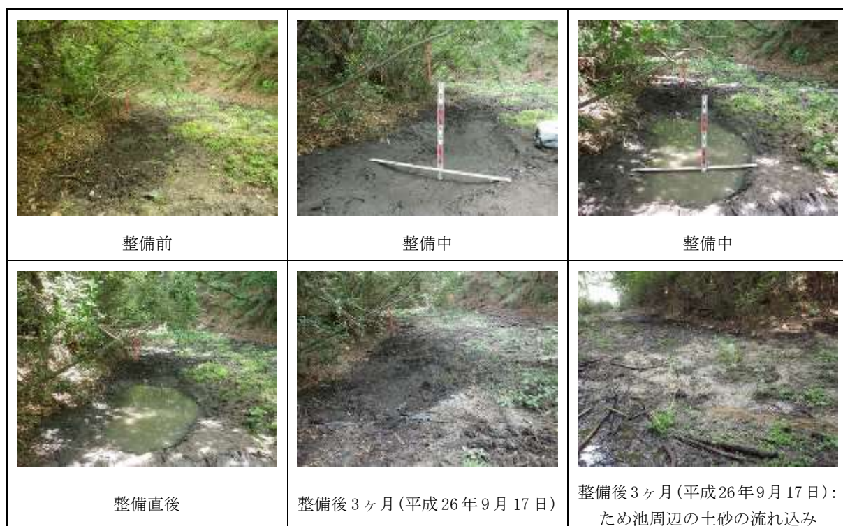
写真 3-4 ため池の環境整備状況
