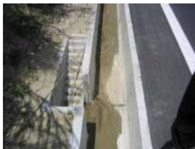
通常の側溝の一部を加工してス ロープを設置するタイプ
