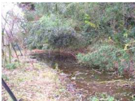
千葉東金道路建設における代替産卵池施工例 出典 伊東英幸「我が国の道路周辺に造成されたピオトープの実態分析とHEPによる環境評価に関する研究」
