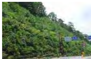
兵庫県の西宮北有料道路南延伸事業における法面緑化施工事例
