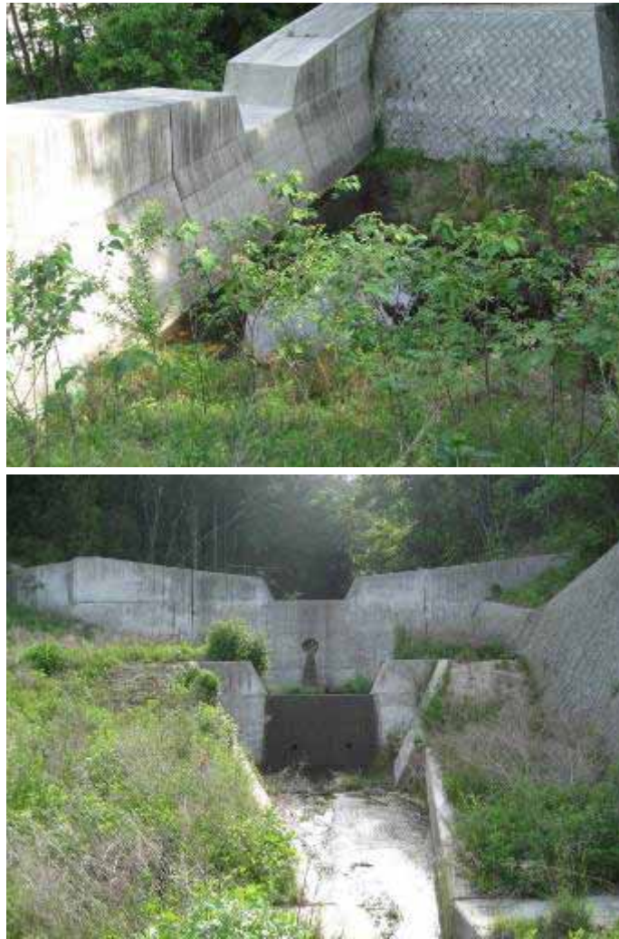
谷止工(コンクリートダム)
