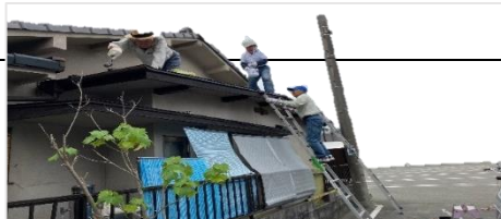
屋根のペンキ塗り作業
