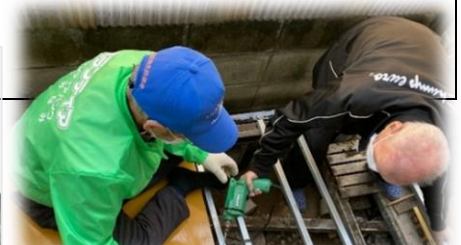
勝手口踏み台の取り換え
