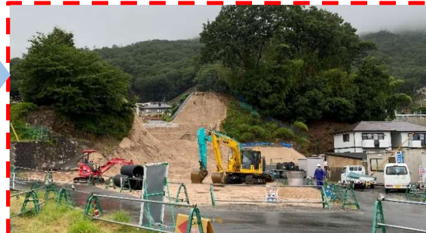
川の内線橋りょう下部工事の様子
