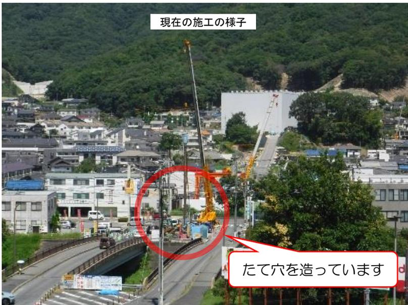
内径3メートルの鉄筋コンクリート管を推進工法(トンネル)により地中に約70メートル埋設する工事です。
