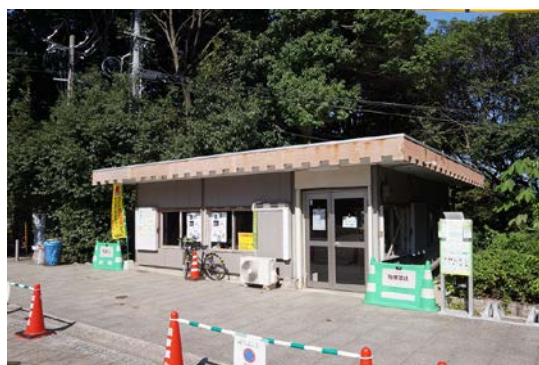
写真:管理事務所の外観
