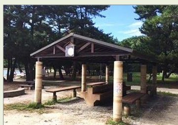
(例) 小戸公園(福岡市)の屋根付き 水場施設
