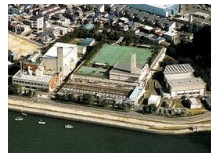
江波水資源再生センター
