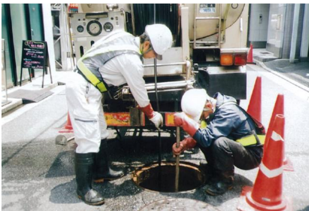
下水道管清掃状況
