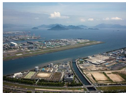
西部水資源再生センター
