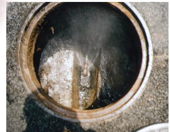
下水道管清掃状況
