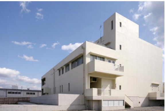
写真 3 西部臨海ポンプ場
