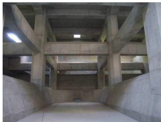
江波雨水滞水池（内部）
