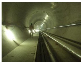
雨水幹線 (千田雨水1号幹線)
