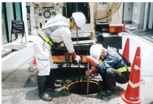
下水道管清掃状況
