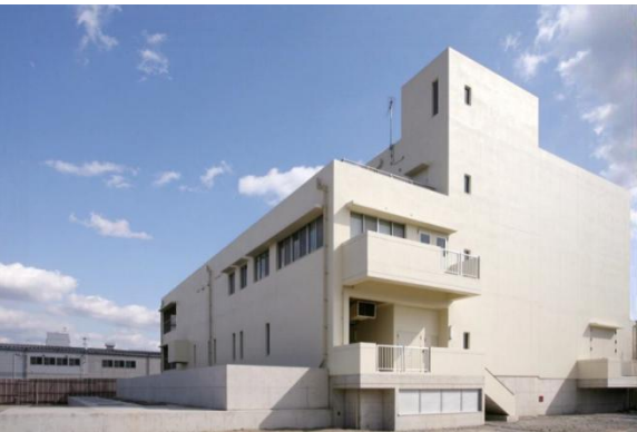
写真 3 西部臨海ポンプ場
