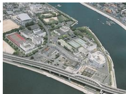
千田水資源再生センター
