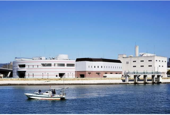
写真 4 新千田ポンプ場
