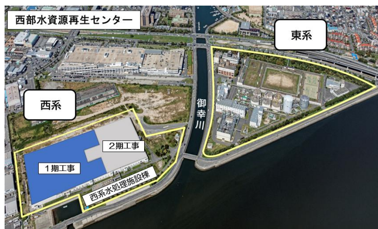
太陽光パネル設置箇所
