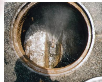
下水道管清掃状況
