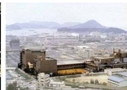
旭町水資源再生センター
