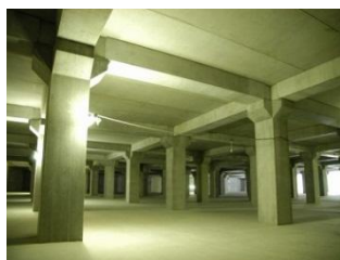
大州雨水貯留池
