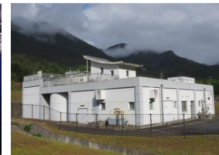
和田水資源再生センター
