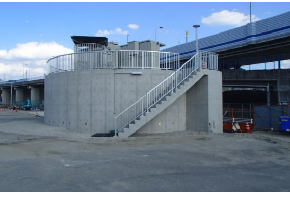
写真 6 新宇品ポンプ場
