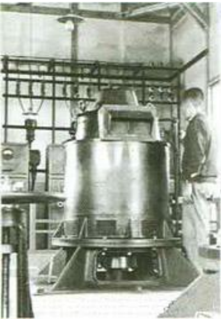
写真 1 新千田抽水所
