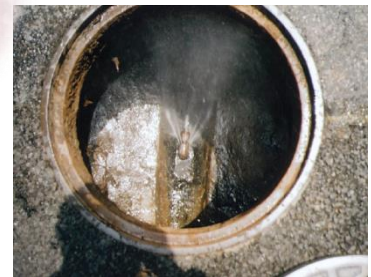
下水道管清掃状況
