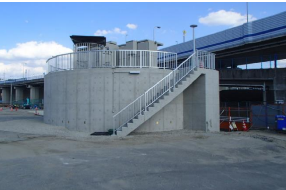
写真 6 新宇品ポンプ場
