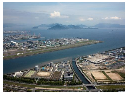
西部水資源再生センター
