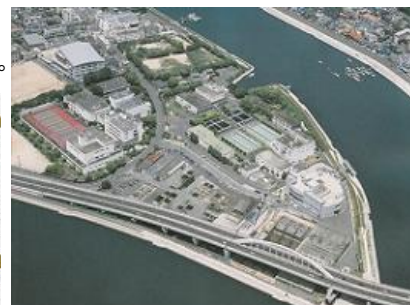
千田水資源再生センター
