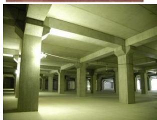
大州雨水貯留池
