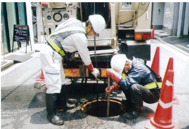
下水道管清掃状況
