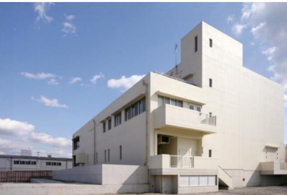
写真 3 西部臨海ポンプ場
