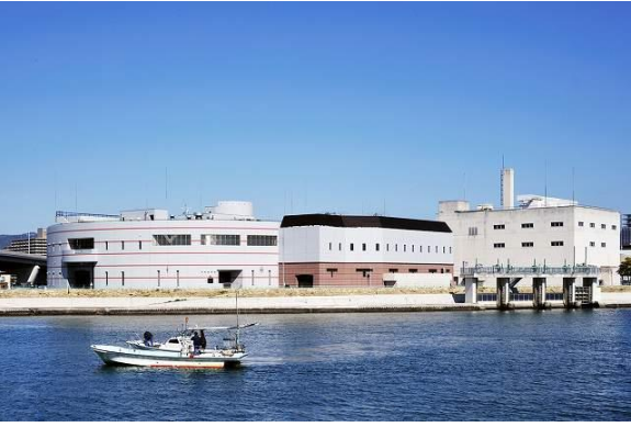
写真 4 新千田ポンプ場
