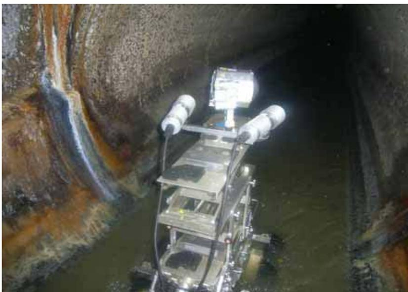
撮影された下水管内部の映像は、1 既設下水管の直径が80cm未満の場合の調査方法と同様に地上部に待機しているテレビカメラ車に送られ、車内の調査作業員がリアルタイムに映像の確認を行います。
