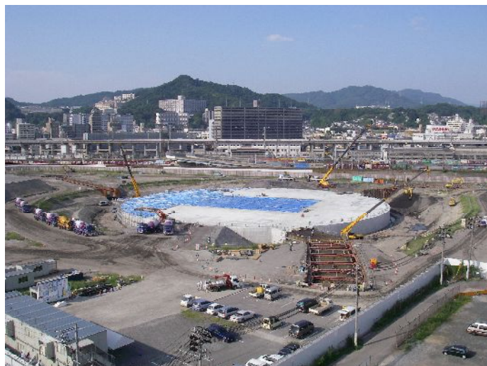
雨水貯留池本体工事状況(H19.9)
