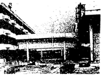
普通教室20室が完成した瀬野川中学校の校舎。
