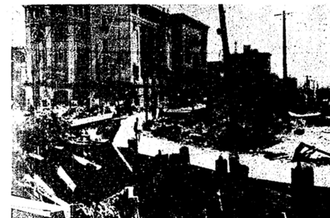
爆心地にもっとも近い広島銀行や住友銀行などの大きな鉄筋の建物は、かろうじてその外形だけを残していました。
