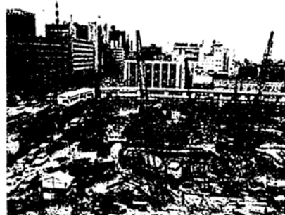
【上】バスセンタービルの完成図 【下】基礎工事が始まったバスセンターの建設現場
