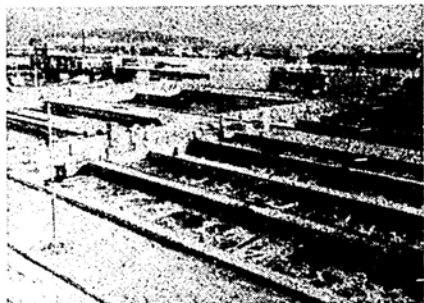
千田下水処理場の全景
