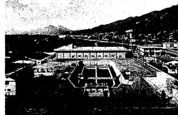
八木取水場の全景＝ここで取水した水が緑井浄水場へ送られます。
