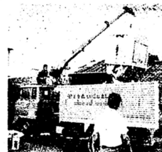
ダスト・ボックスの設置作業
