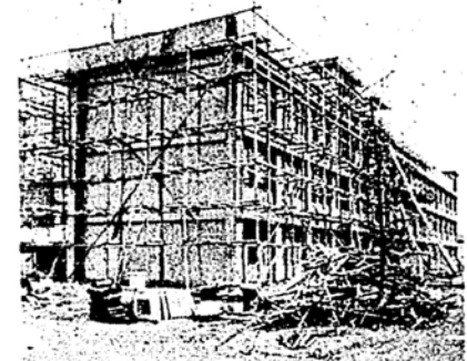
増築中の工業高校校舎
