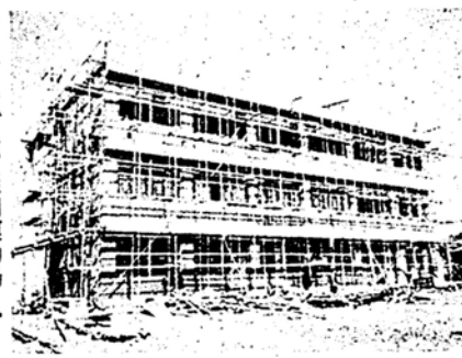
建設中の翠町小学校校舎
