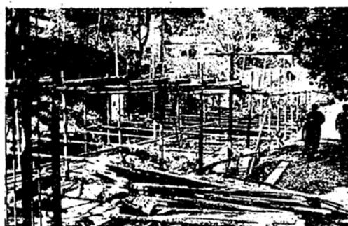
精神薄弱児通園施設の建設工事
