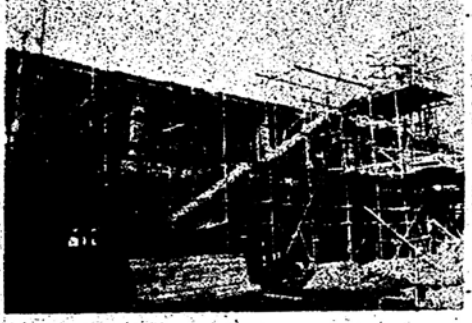
荒神保育園の新築工事
