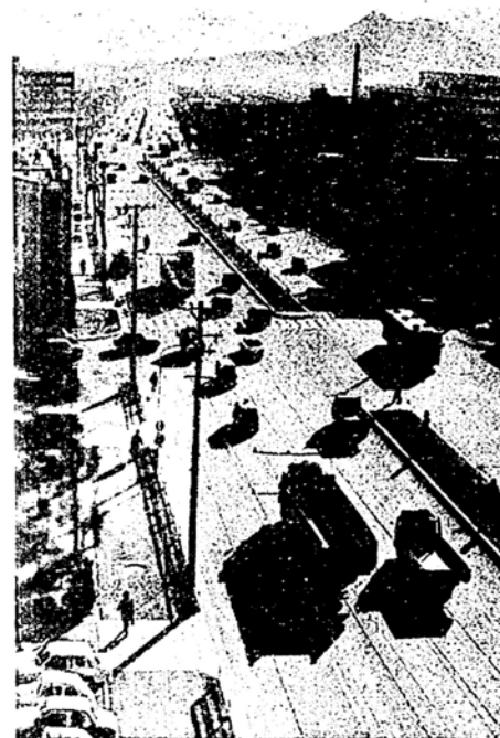
新広島国道が貫通
