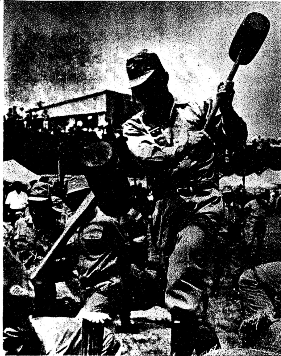
積み土俵のクイ打ち作業＝太田川放水路における総合防災訓練で
