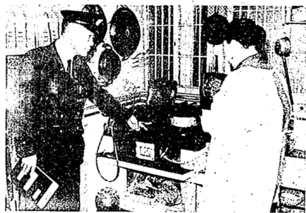
消防査察員は、定期的に一般家庭を巡回して器具の取扱いなどを指導します
