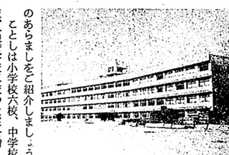
市商の校舎増築工事（右側へ）が行なわれます
