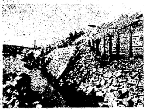
護岸工事を進めている大洲埋立て地
