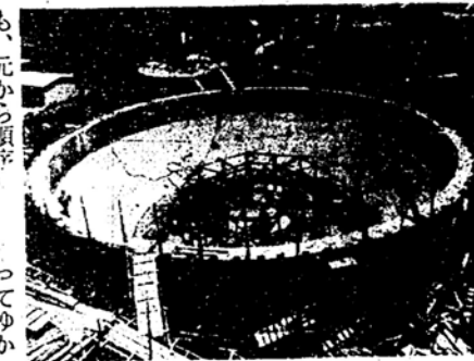
七月末完成をめざす水源地内のふたつの増設貯水池
