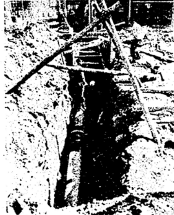
配水管の敷設工事進む＝大芝小学校付近で
