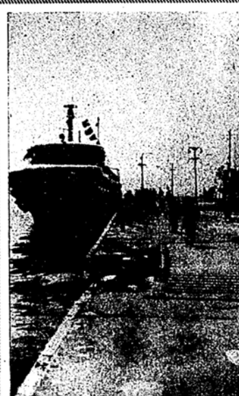
増設工事によって、大型船もろくに接岸できるようになった市営桟橋
