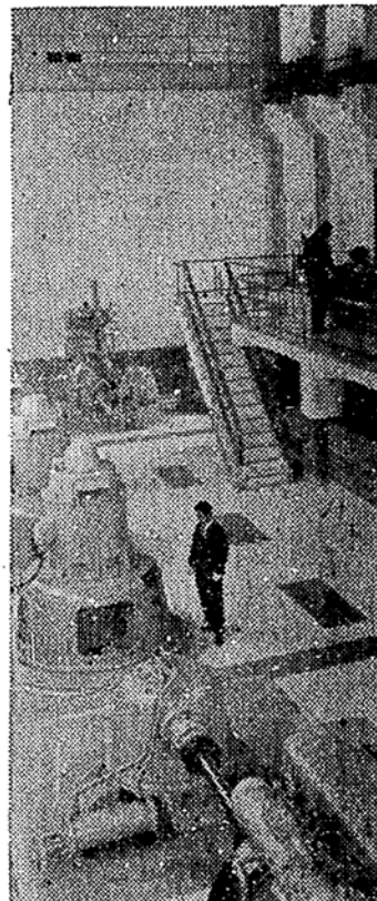
千田ポンプ場
