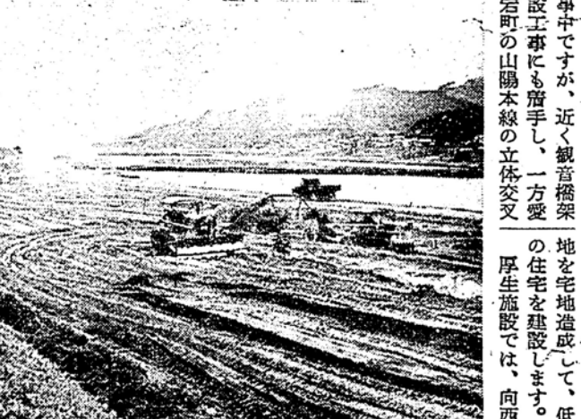
写真は太田川放水路の工事
