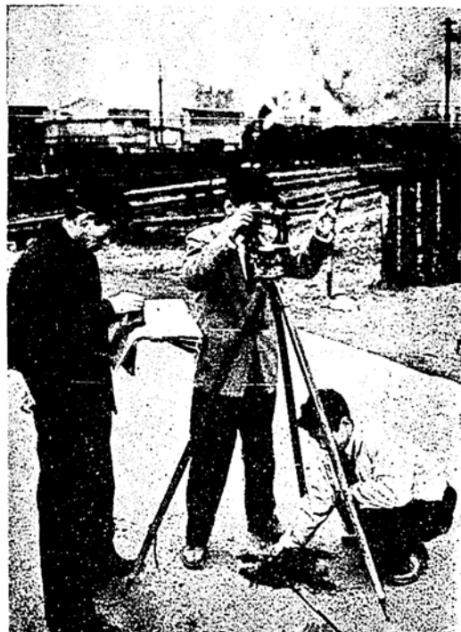
都市区画整理事業も約80%の進捗、いよいよ最後の仕上に。この写真は広島駅愛宕踏切附近の確定測量で、将来この線路に陸橋がつけられる予定です。
