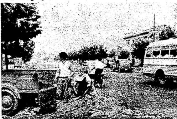
写真は道路舗装工事
