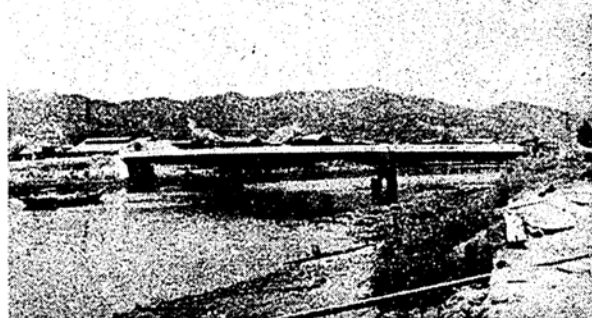
写真は1日完成の広瀬橋
