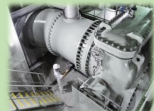
広島市最大の雨水ポンプ（新千田ポンプ場）
