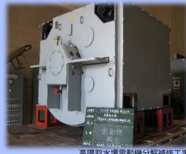
高圧取水場電動機分解補修工事
