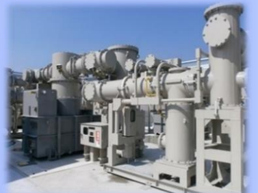
受変電設備取替工事
