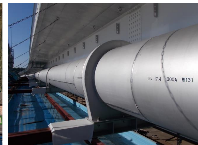
■ 水道施設の整備・更新 (広島南配水幹線) ■
