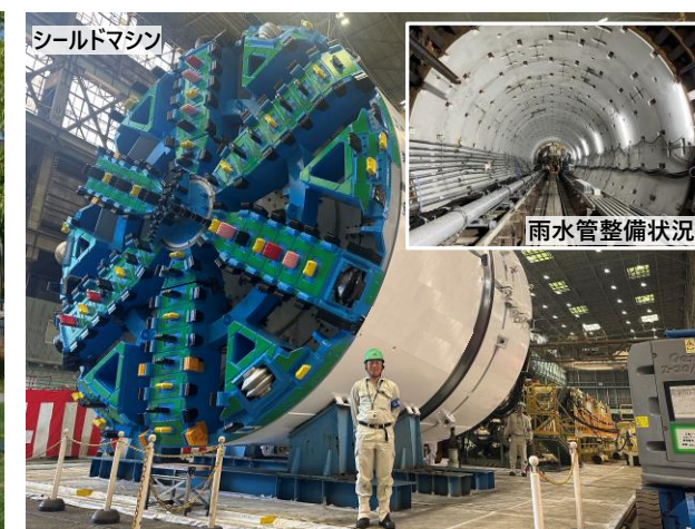
■ 下水道施設の整備（浸水対策） (観音 2 号幹線) ■
