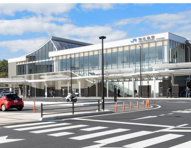
■ 西広島駅自由通路等の整備 ■
