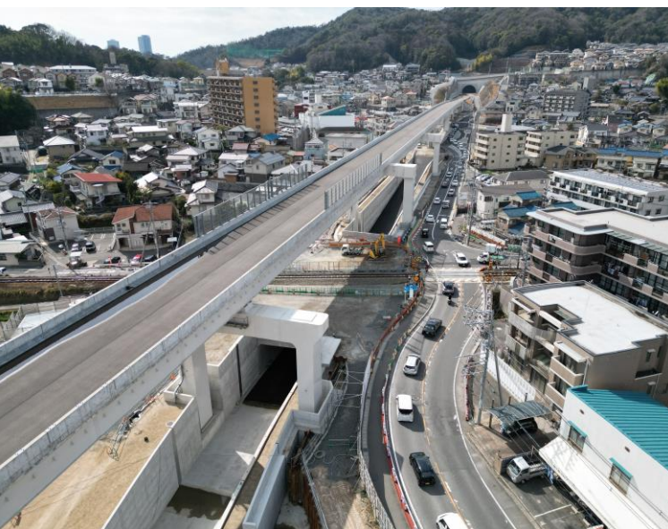
■ 広島高速道路の整備 (広島高速 5 号線) ■
