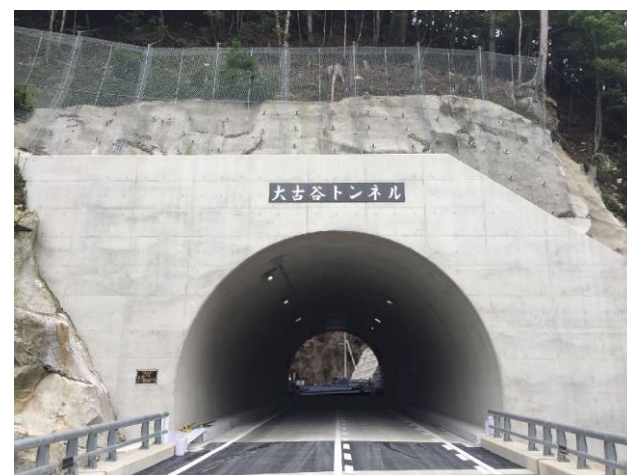
■ 幹線道路の整備 (一般国道433号 大古谷トンネル) ■
