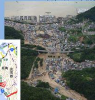
安芸郡坂町小屋浦
