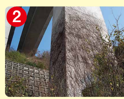
山陽自動車道の橋脚 (約70m)
