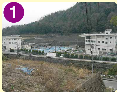
白ヶ瀬浄水場 (中面に表示)
