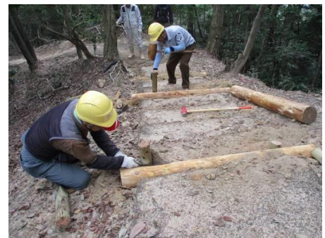
傷んだ遊歩道を補修する様子
