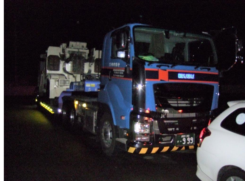
吹付ロボット搬入状況
