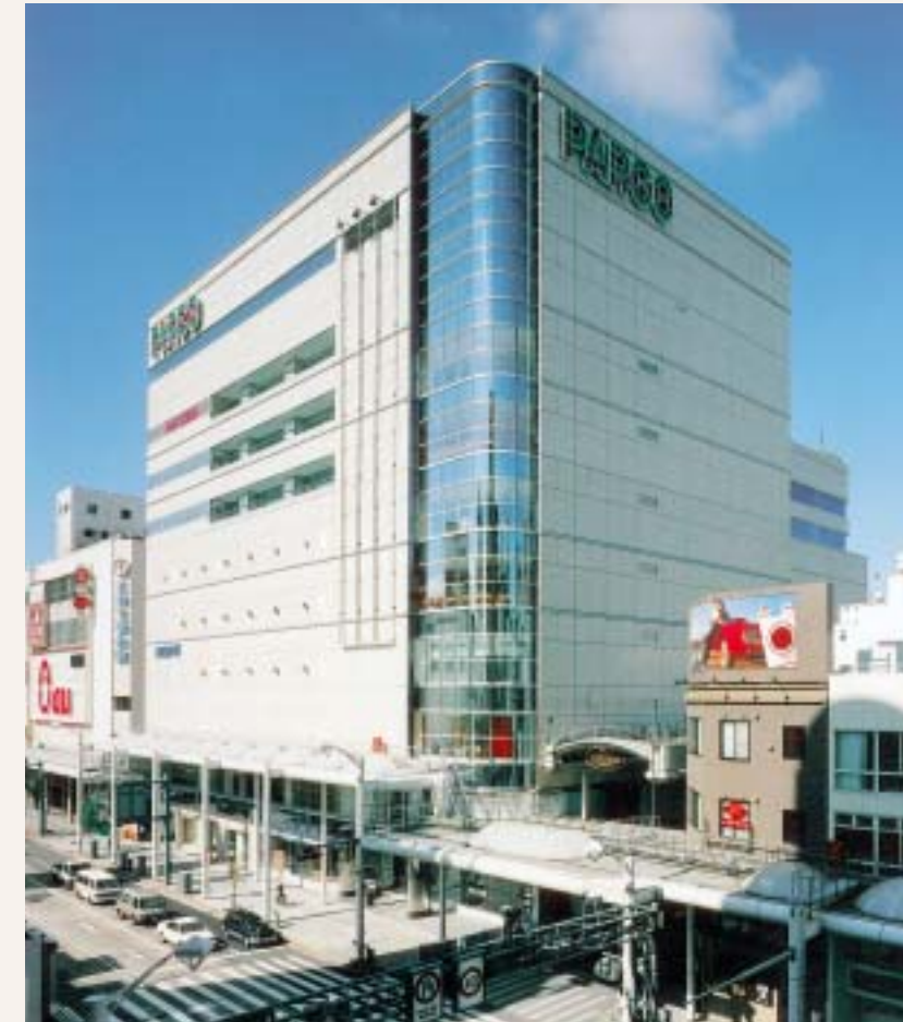
金座街地区第6街区 Kinzagai District (Zone 6)
